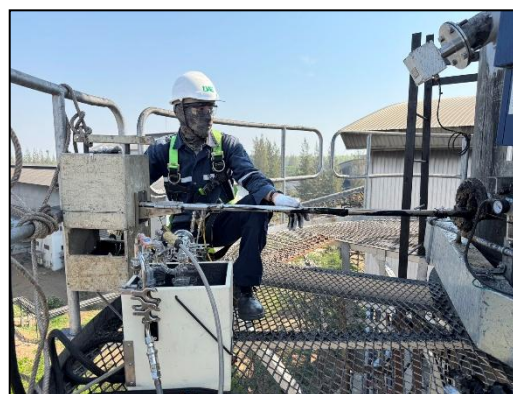
(3) ปล่อง Boiler (Inlet): Soot Blow
