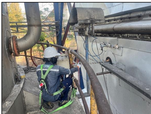
(3) ปล่อง Boiler (Inlet): Soot Blow
